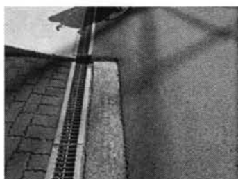
写真3 目地や排水溝の蓋 2014年10月24日撮影
