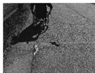
写真5 道路の割れ目 2014年10月24日撮影
