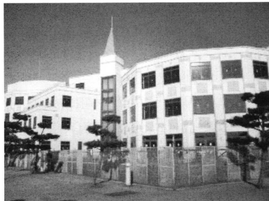
写真2 未完成のまま取り壊されたダイニングスタジオおおくら海岸
