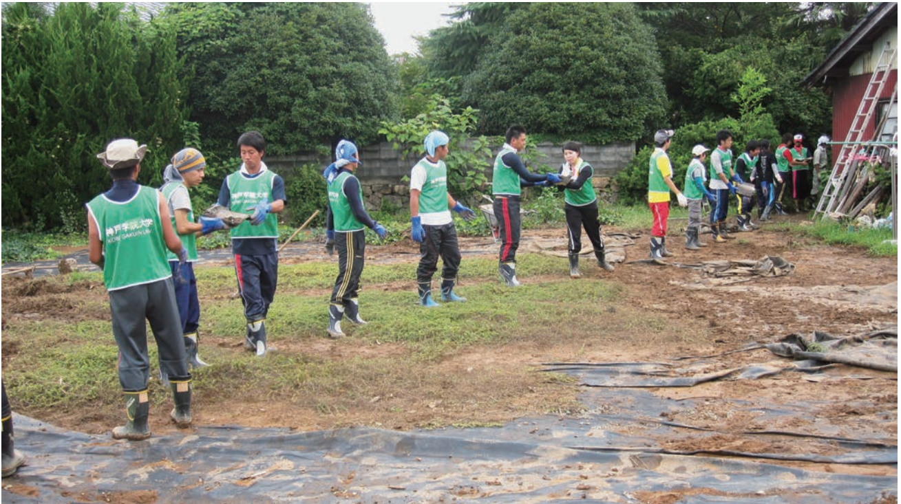
泥で汚れた瓦をバトンリレー（兵庫県丹波市）
